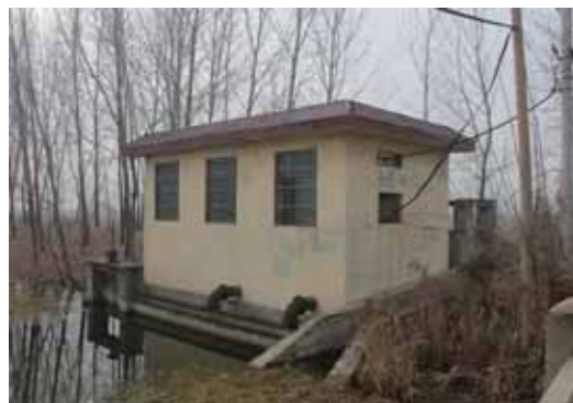
照片 2.6-9 复垦后配套的排灌站
