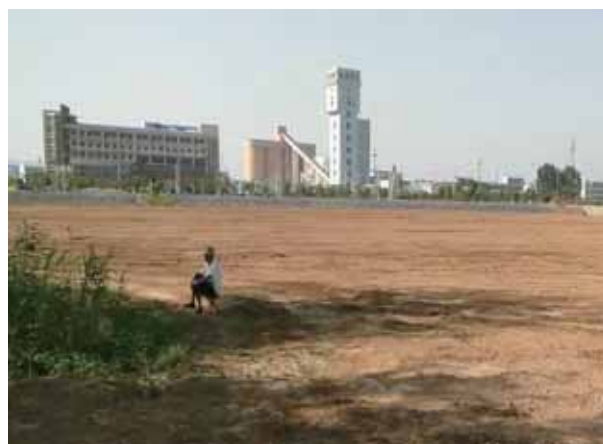
照片 2.6-3 复垦充填后场地平整
