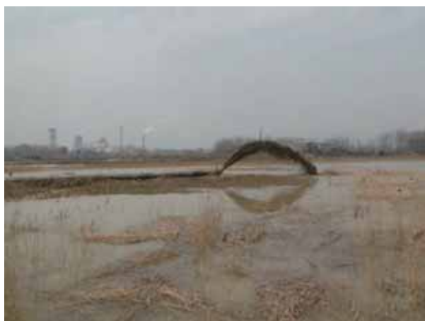
照片 2.6-2 湖泥充填施工现状
