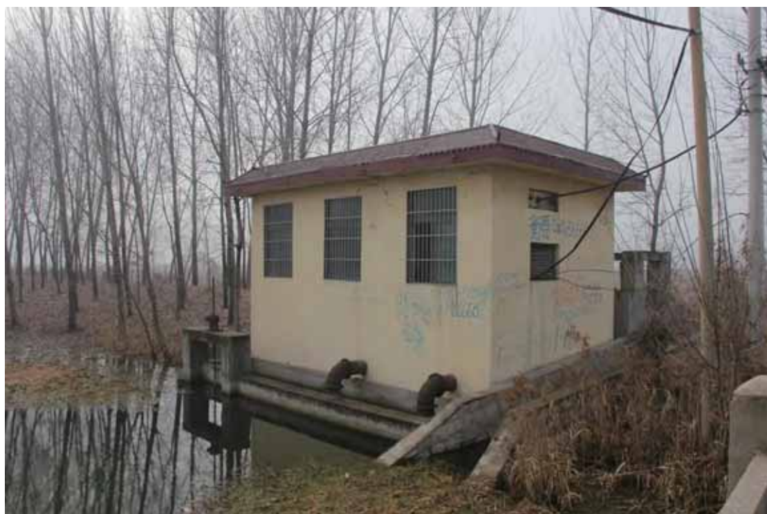
照片 5.3-2 矿区现有泵站现状
