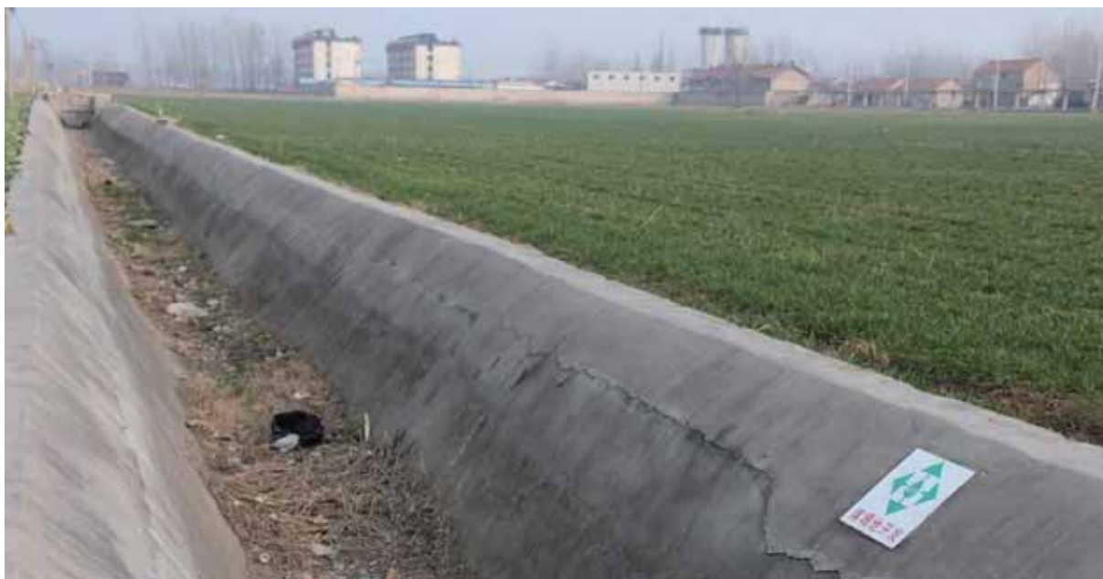
照片 3.3-4 塌陷复垦区配套的沟渠现状照片
