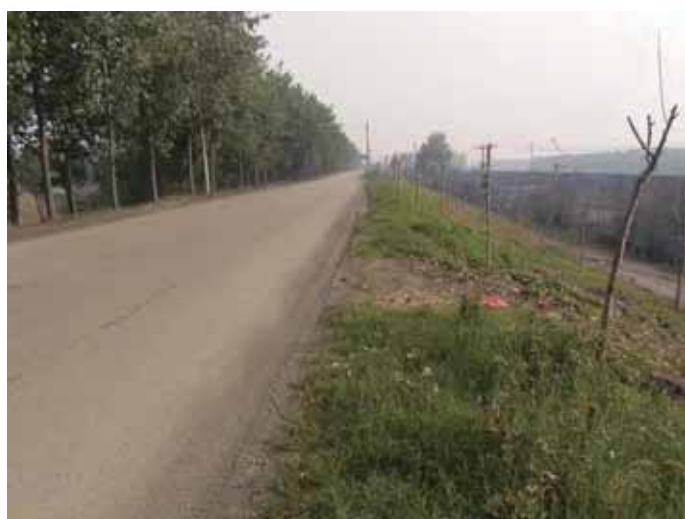
照片 3.2-4 加固后已稳沉区湖西大堤
