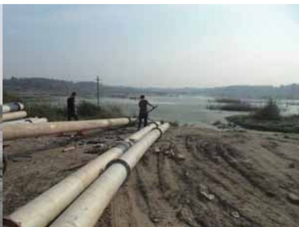
照片 2.6-15 复垦现场照片
