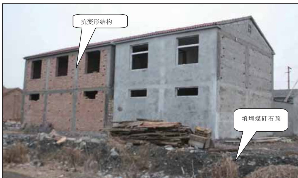
照片 2.6-1 抗变形结构房屋
