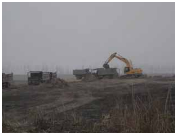
照片 2.6-11 复垦现场照片
