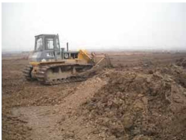
照片 2.6-10 复垦现场照片
