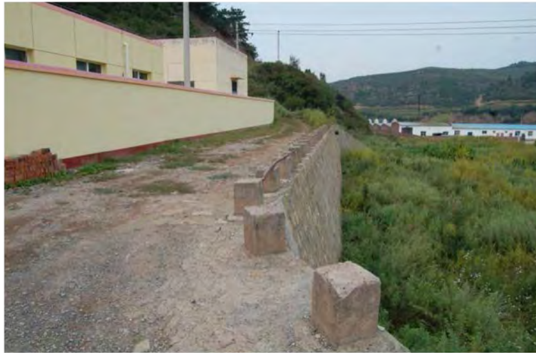
图 2-35 集气站护坡
