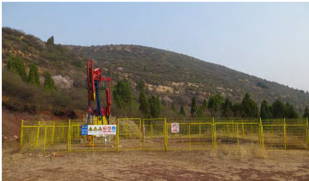
图 3-4 已建井场现场照片
