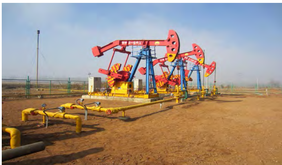
图 1-17 已建井场现场照片
