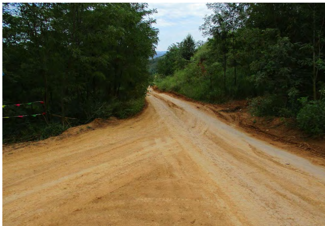
图 1-18 进场道路现场照片
