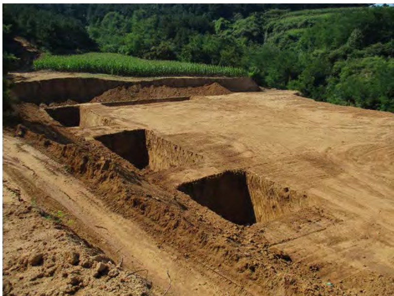
图 3-21 井场施工前期土地平整表土剥离
