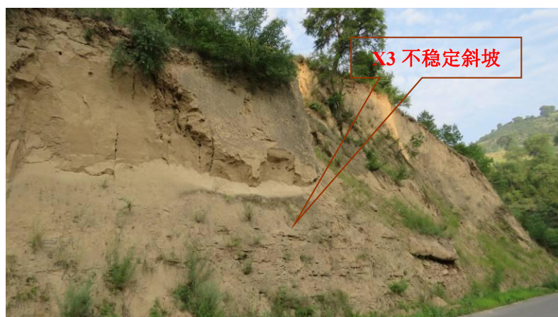
照片 3-10 X3 不稳定斜坡
