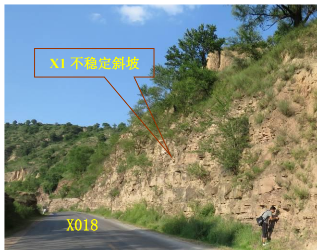
照片 3-8 X1 不稳定斜坡
