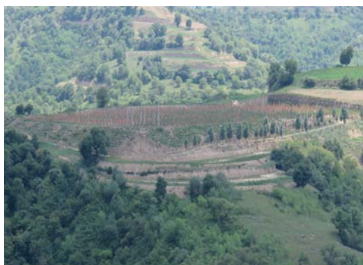
照片 3-13 午 51 井场开挖场地平整
