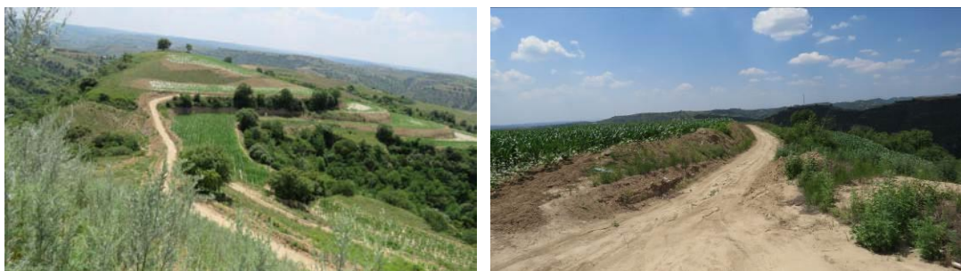
照片 1-5 井场道路占地
