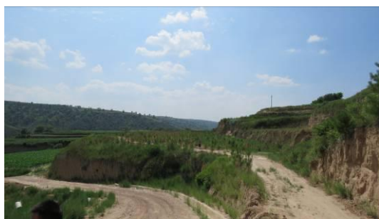
照片 3-15 黄渠村井场道路
