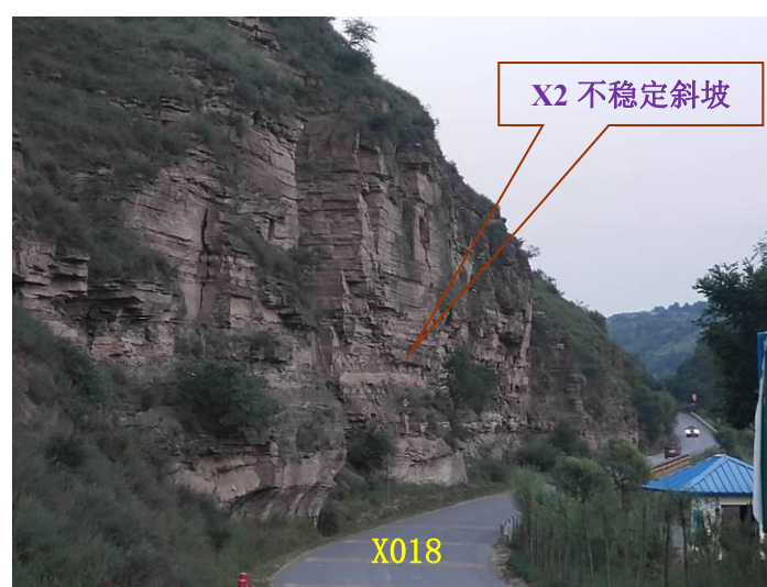
照片 3-9 X2 不稳定斜坡
