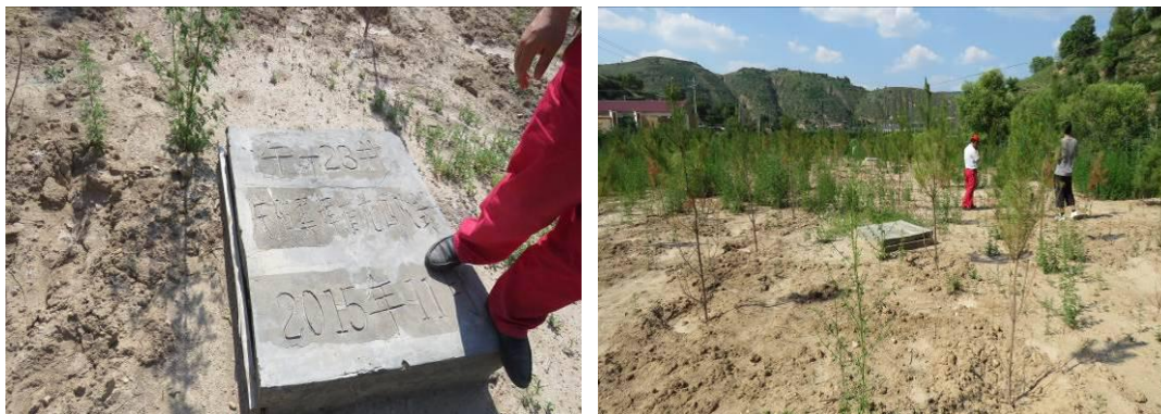
照片 2-13 午 59 井场已经封堵的采油井
