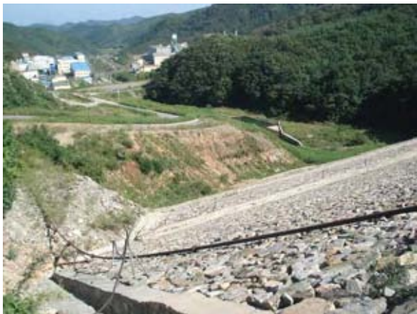
照片 3-4 铀尾矿库边坡和选矿厂
