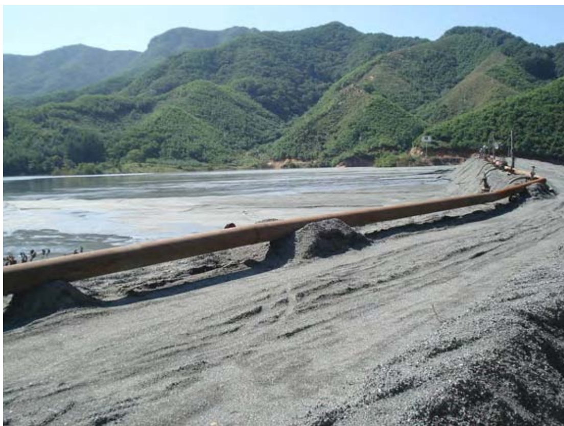
照片 2-3 尾矿库及周围地形地貌
