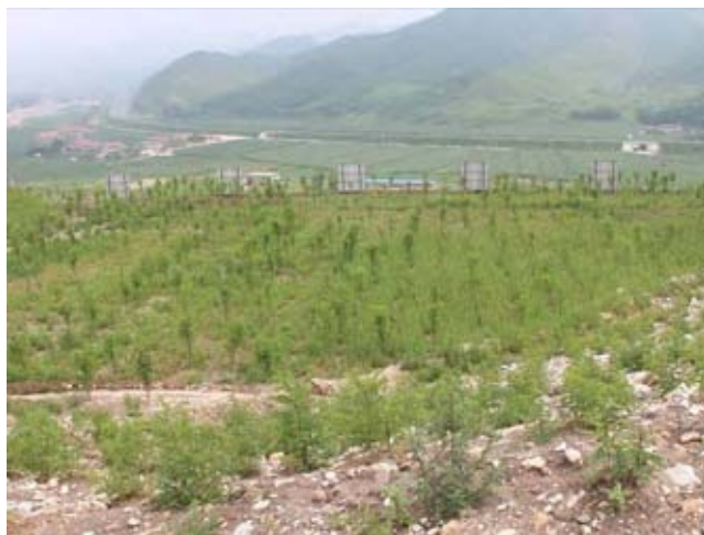
照片 2-14 平台治理竣工
