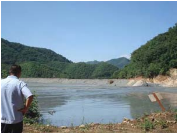
照片 3-3 硼铁尾矿库现状照片
