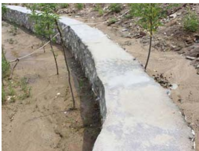
照片 2-21 浆砌石挡土墙
