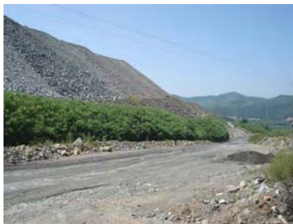
照片 3-2 排土场边坡
