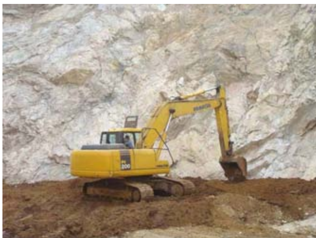
照片 2-15 采场平台客土
