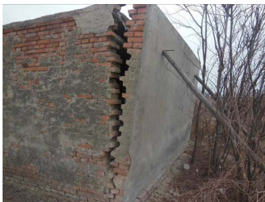
照片 3-15 董庄子院墙裂缝
