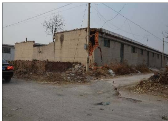
照片 3-14 何家庄房屋裂缝
