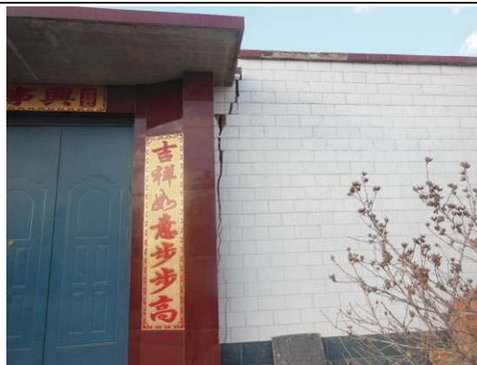
照片 3-16 大荣各庄院墙裂缝
