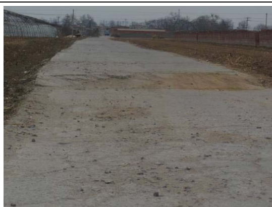
照片 3.3-4 地面塌陷损毁道路
