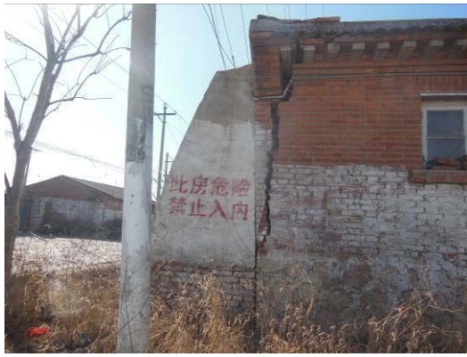
照片 3-17 大荣各庄墙体裂缝
