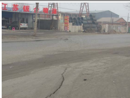
照片 3.3-6 地面塌陷损毁道路
