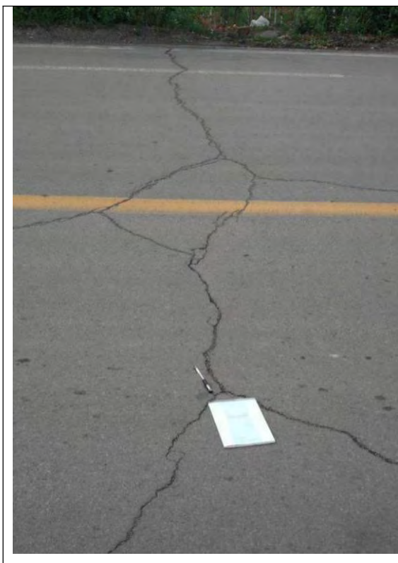
照片 3-2-28 2201 工作面官三线地裂缝
