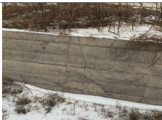
照片 3-2-24 尧泽头村水渠裂缝
