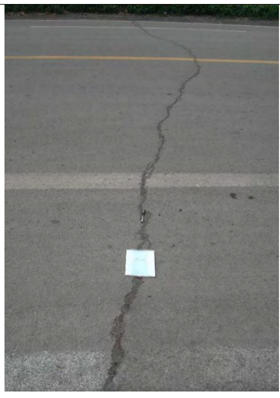
照片 3-2-29 2202 工作面官三线地裂缝
