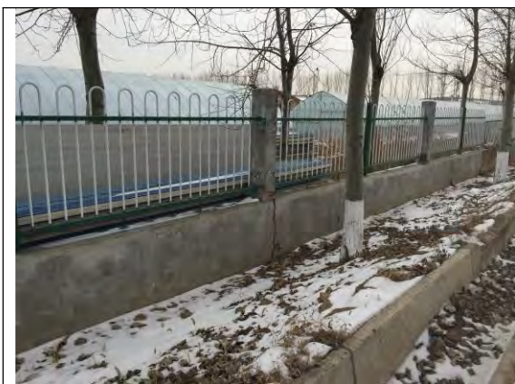
照片 3-2-23 莲村蔬菜大棚墙体裂缝
