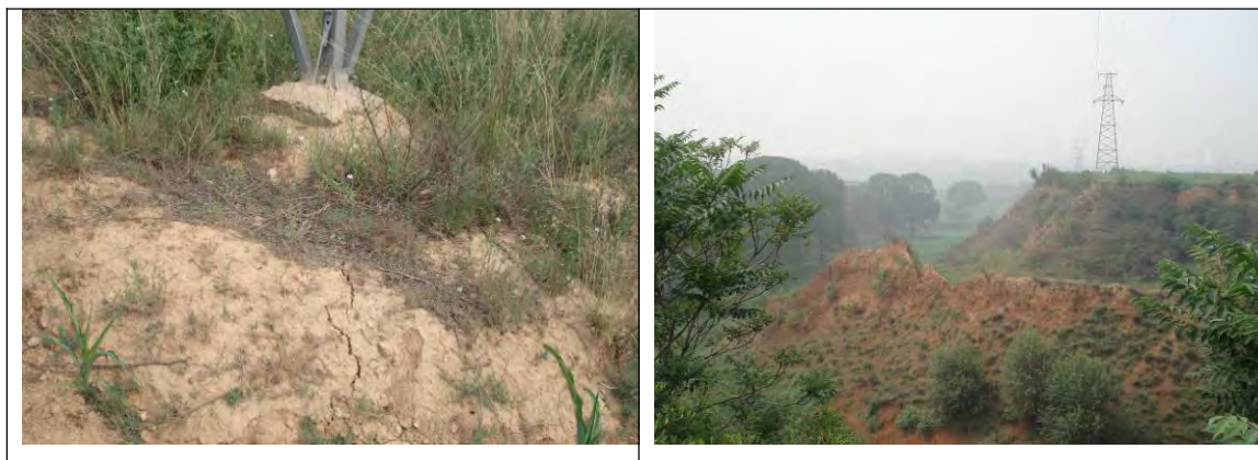
照片 3-2-31 N1201 工作面上方高压塔周边裂缝
