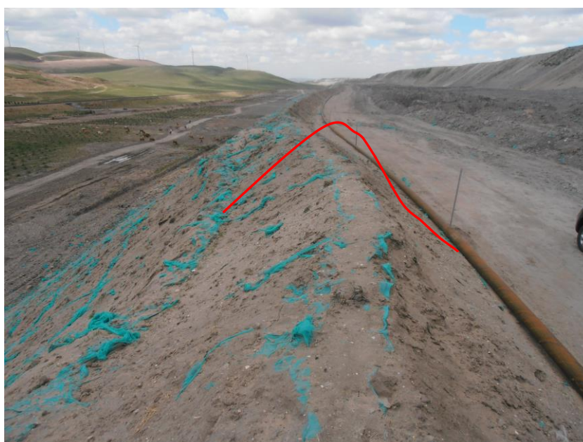
图 2.6-2 外排土场台阶挡土墙
