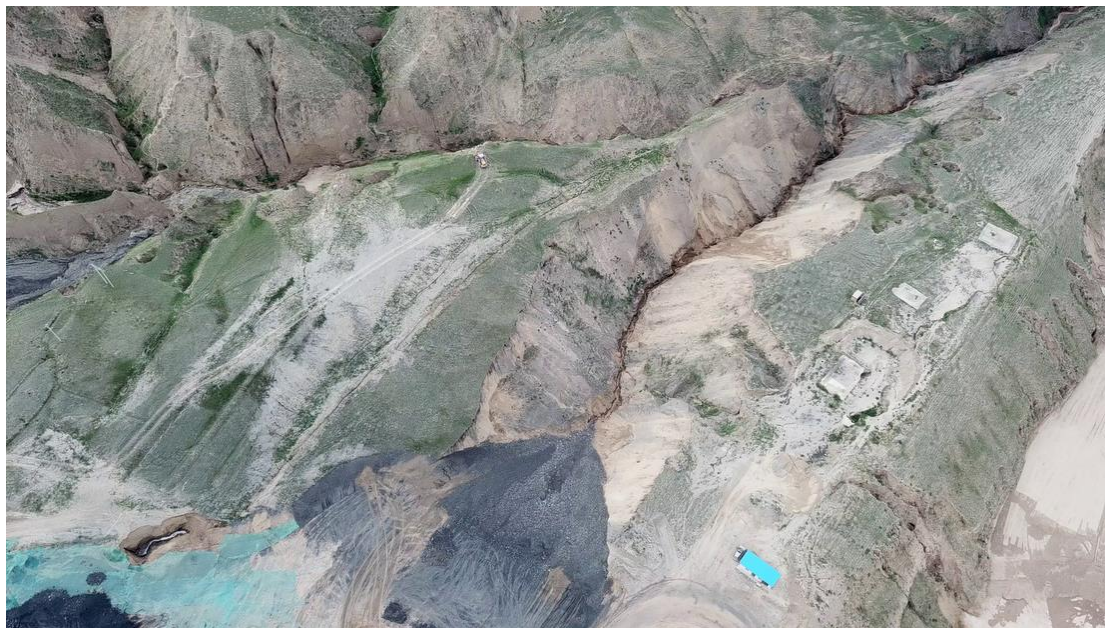
照片 3-6 排矸场区域俯拍照片
