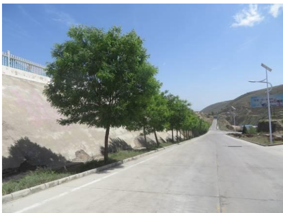
照片 2-25 工业场地道路硬化及植树
