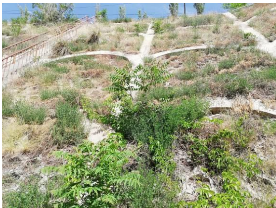
照片 2-19 工业场地护坡工程
