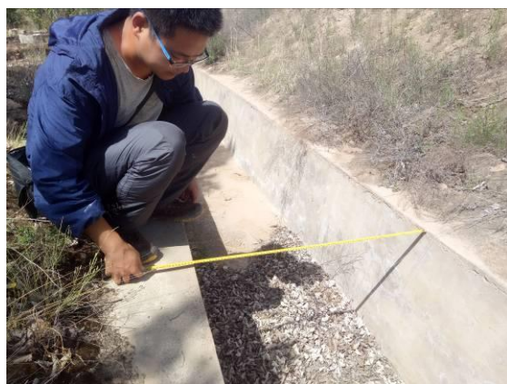
照片 2-22 排水渠工程
