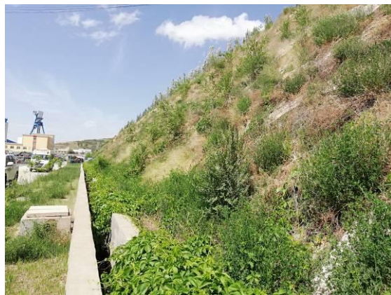
照片 2-20 工业场地护坡及排水渠工程
