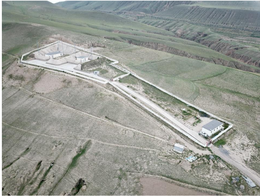
照片 1-3 爆破器材库航拍全貌
