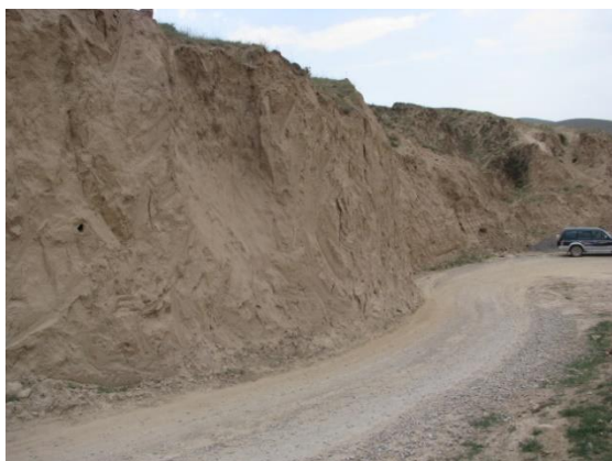
B2 矿区中部崩塌远景
