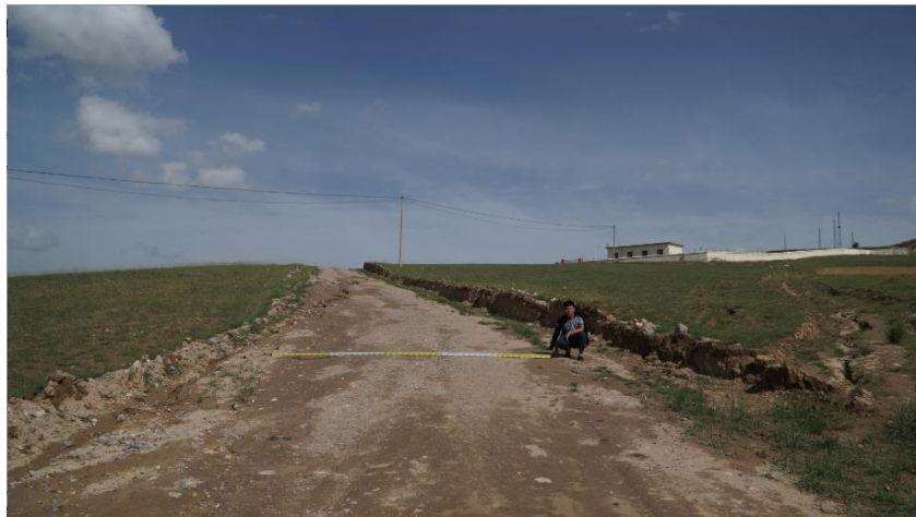
照片 1-4 爆破器材库道路宽度测量
