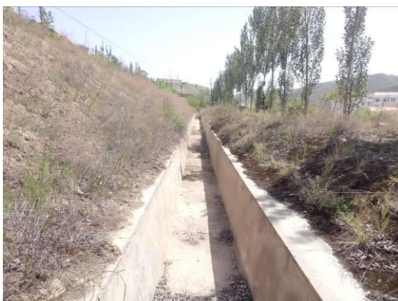
照片 2-21 工业场地坡顶排水渠及防护林带
