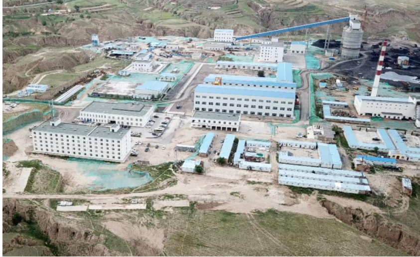
照片 1-1 工业场地航拍全貌
