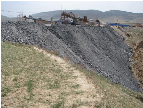
工业场地北侧 100m 处 X1 不稳定斜坡
