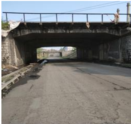
照片 2.5-6 进矿公路
