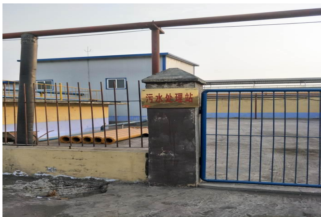
照片 1.3-10 九龙矿污水处理厂
