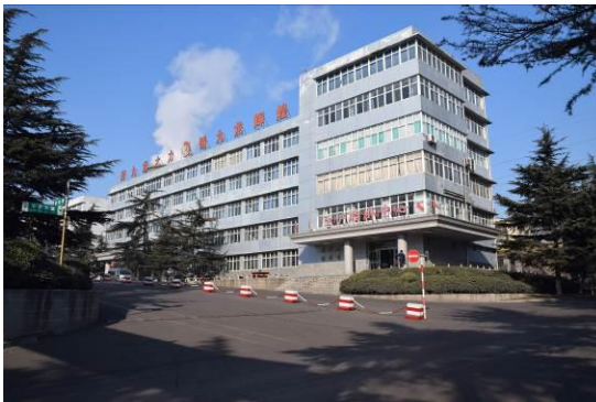
照片 1.3-8 指挥中心大楼
