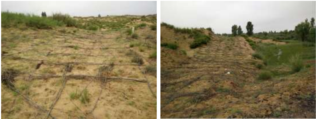
照片 2-3 麦草固沙方格现场照片
