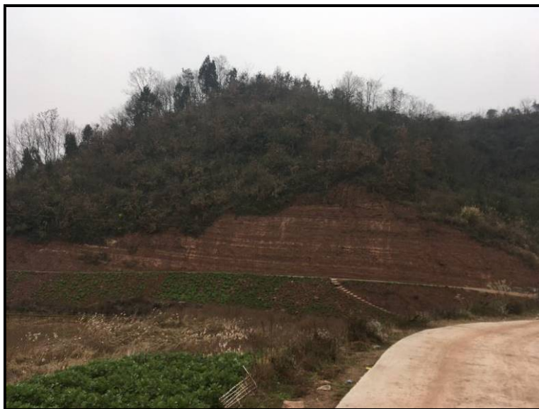
图 3-17 H1 滑坡隐患点现状图（未治理）
