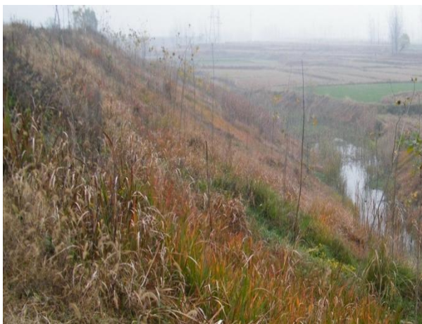
图 3-4 尾矿库坝体现状
