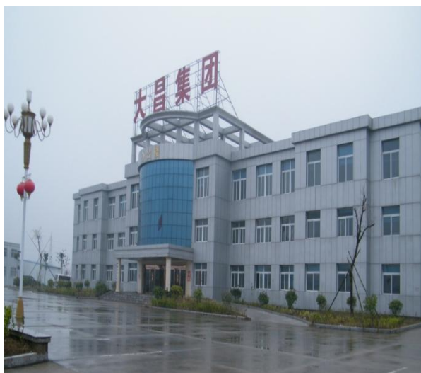
图 3-22 调度办公楼现状
