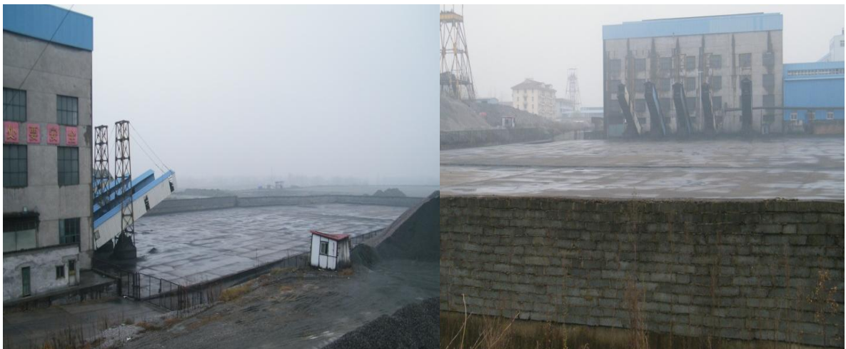
图 2-26 精矿场地硬化加固现状
