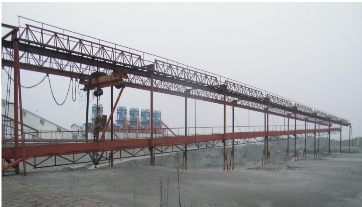
图 3-19 尾矿分级处理场地现状照片
