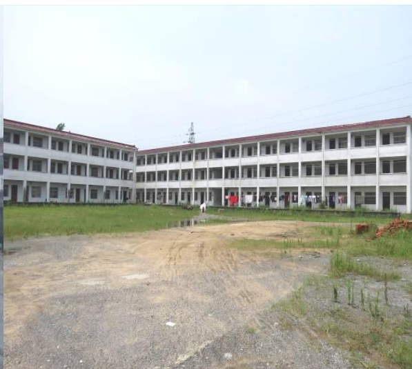
3-22(续三) 路南职工宿舍楼
