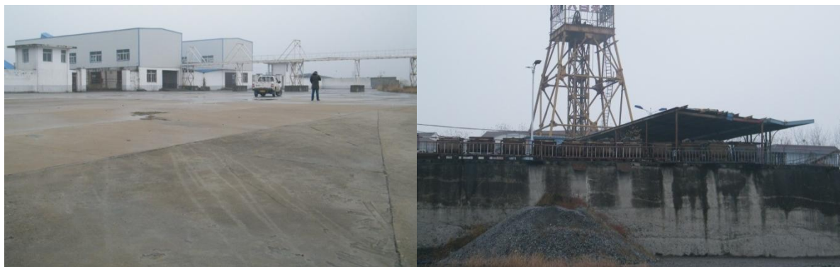
图 2-27 工业广场、矿台硬化加固现状
