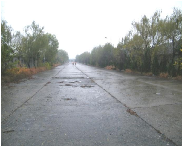
图 3-26 矿区道路现状
