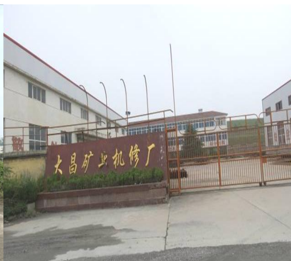
图 3-24(续) 机修厂现状
