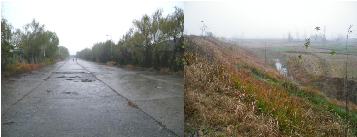
图3-29厂区道路现状
