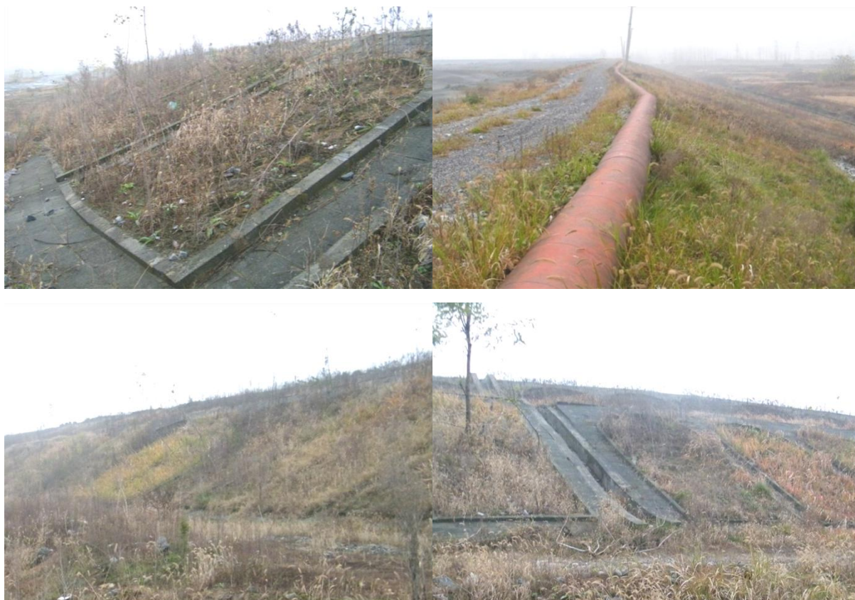
图 5-1 尾矿库坝体加固
