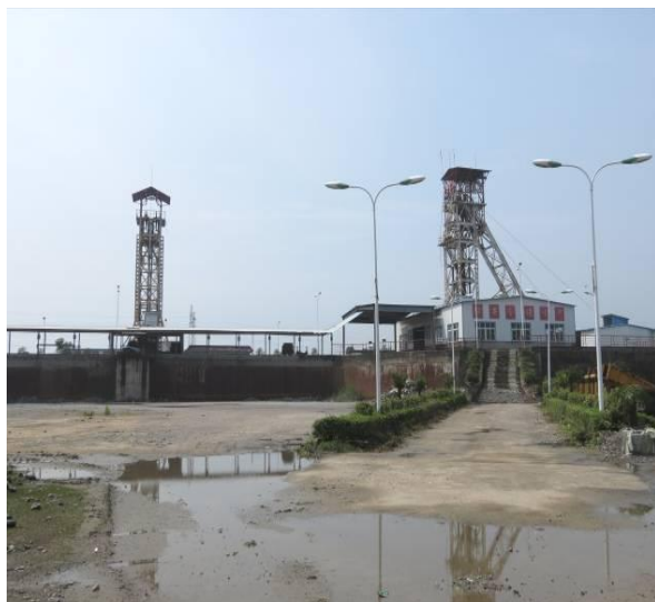
图 3-20 5#主副井场地现状
