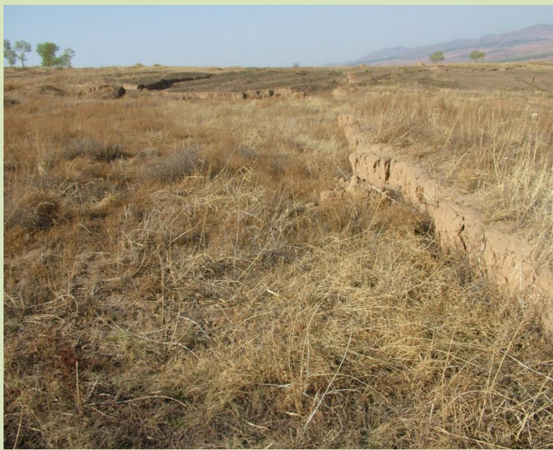
照片 2-27 治理前采空塌陷区
