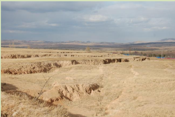
照片 3-4 采空塌陷后形成的陡坎
