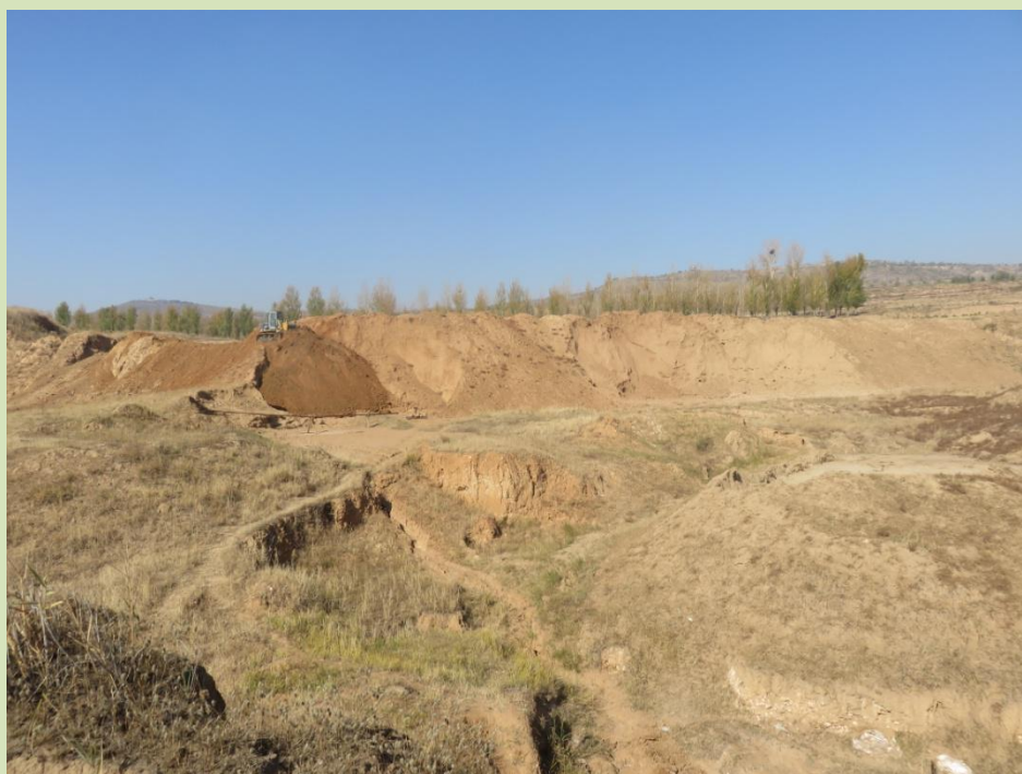
照片 2-24 古山煤矿回填治理中
